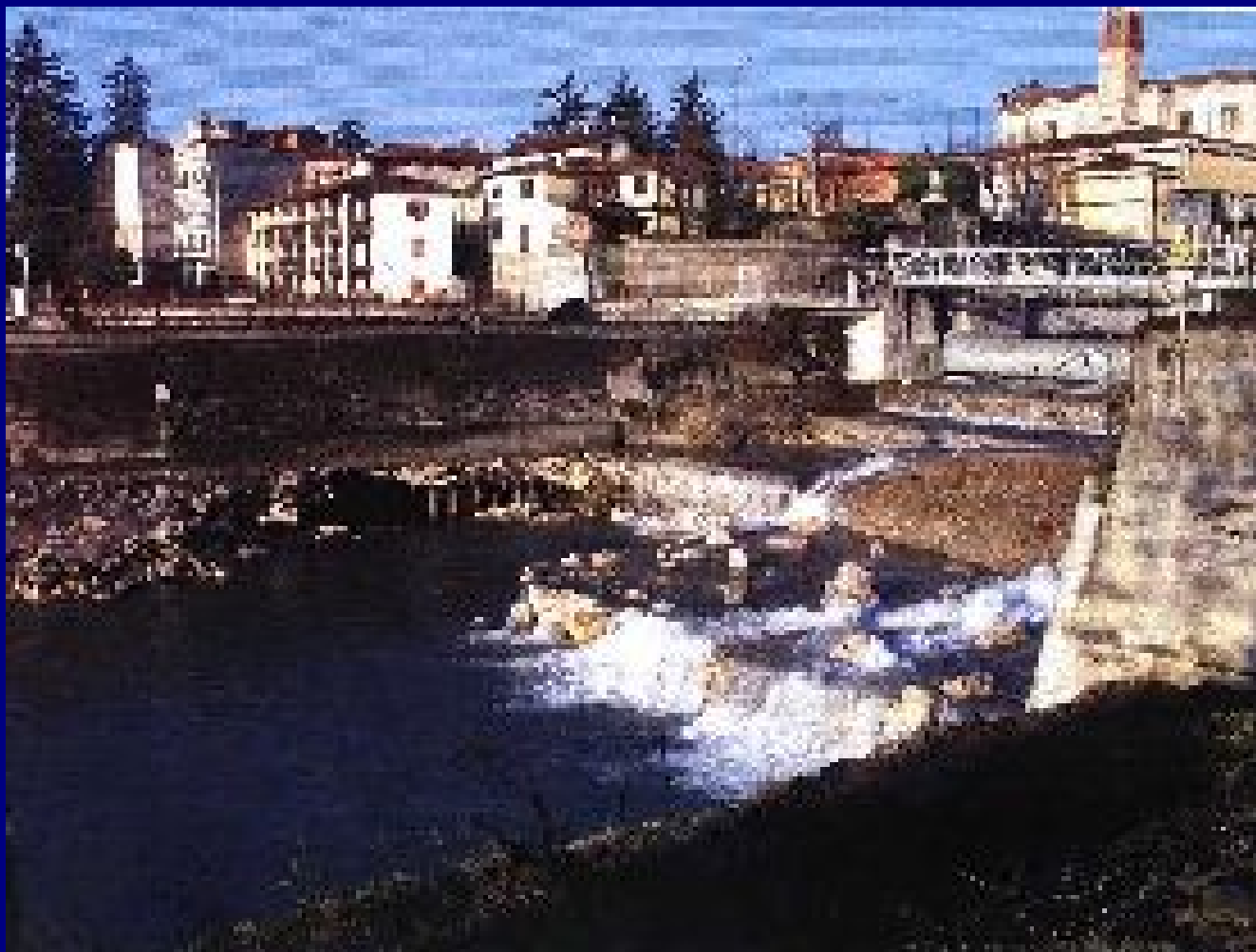
Opere di presa ENEL sul Fiume Brembo - Comune di Ponte San Pietro
