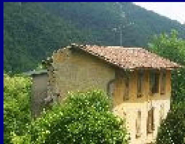
Gli edifici coinvolti
