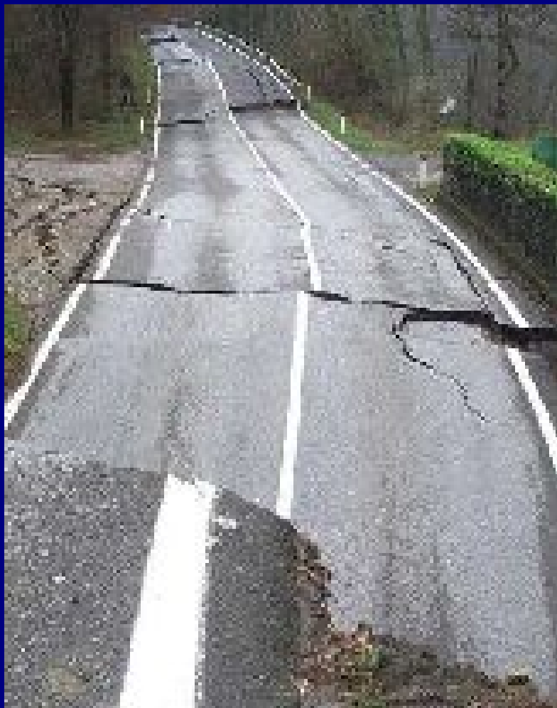
La Strada Provinciale SP14
